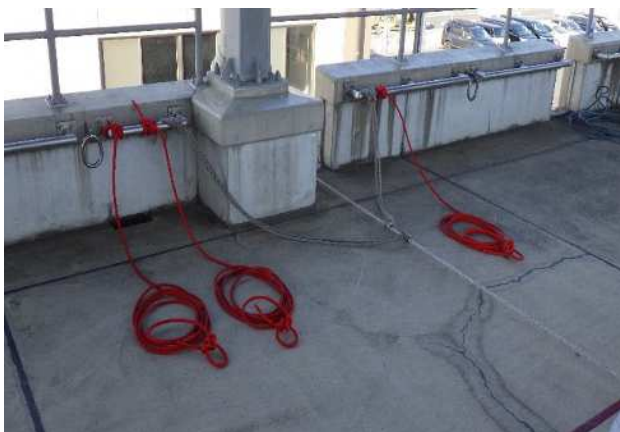
【写真1】 B塔側
